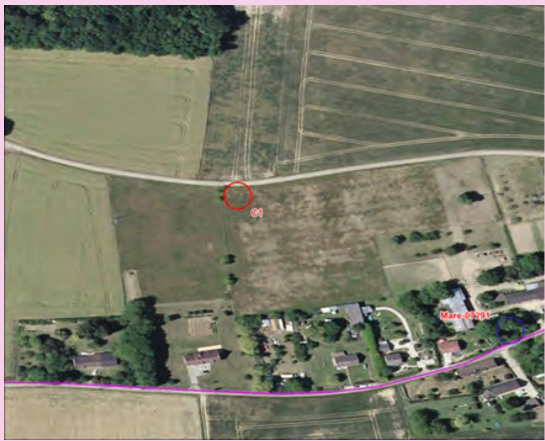
Création d'une mare à Bussy-le-repos
